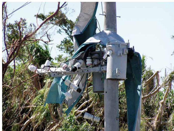
台風により飛来物が引っ掛かった構内柱
