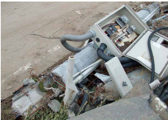
津波により倒壊した引込柱
