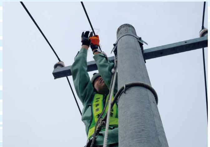
地震により外れた電線の取付け
