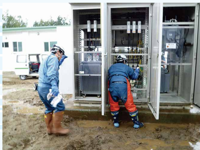
集中豪雨により冠水した受電設備の点検
