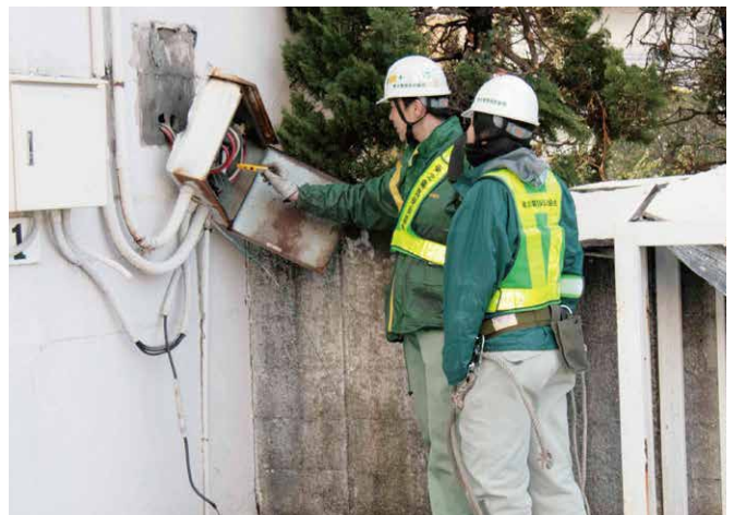
地震により損壊した分電盤の点検
