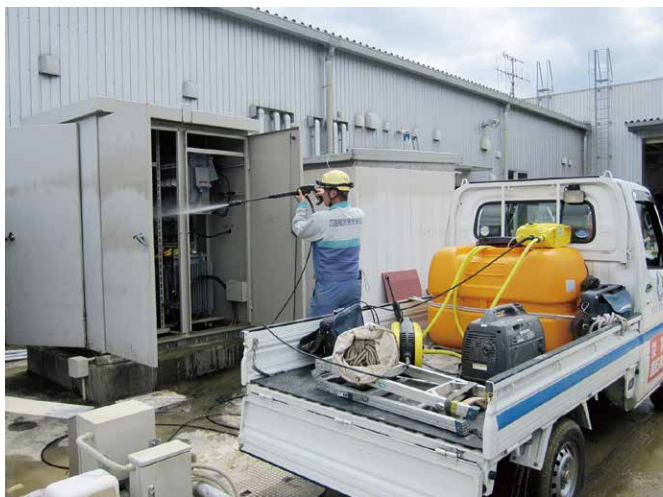
集中豪雨により冠水した受電設備の洗浄
