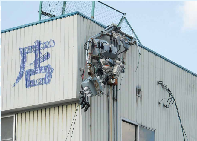
津波により区分別閉器が損壊
