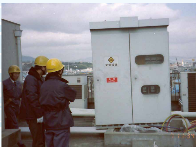
地震により受電設備が傾斜
