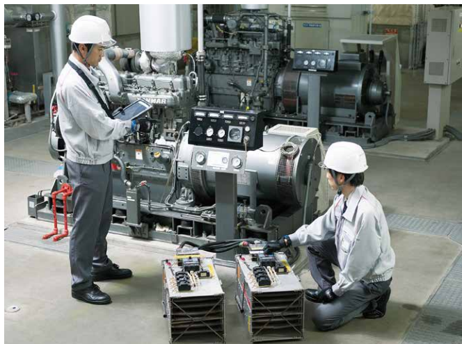
運転性能を確認する負荷試験等
