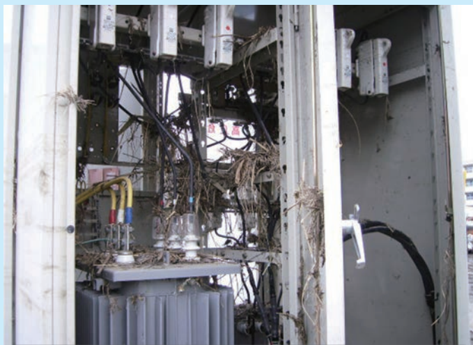
津波により瓦礫が流入した受電設備（キュービクル）（確認）
