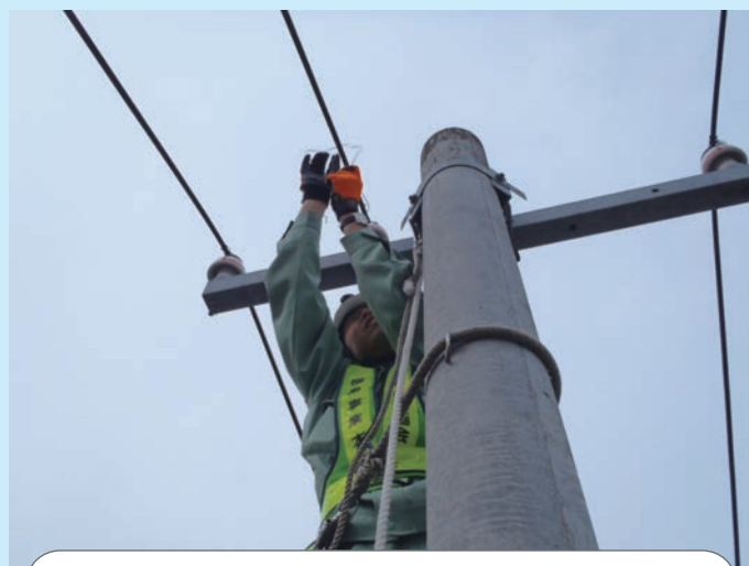
地震により外れた電線の取付け（応急措置）
