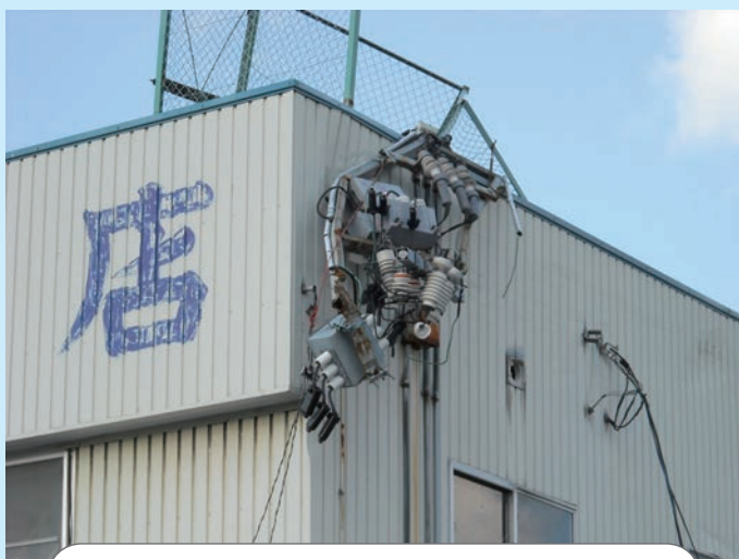
津波により区分別閉器が損壊（確認）
