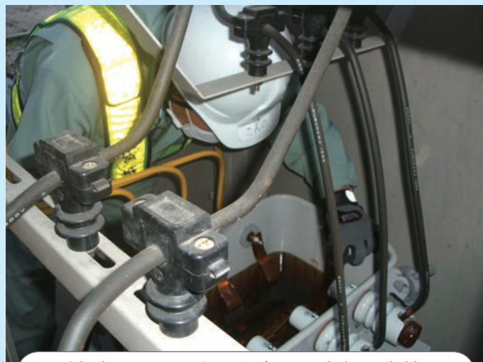
津波により冠水した変圧器内部の点検
