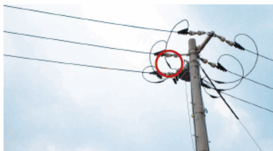
(写真1) 構内柱全景(赤丸部が今回改修箇所)
