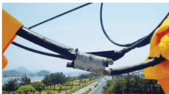
(写真3) 改修工事中
