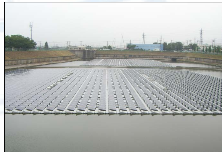
水上に設置した例
