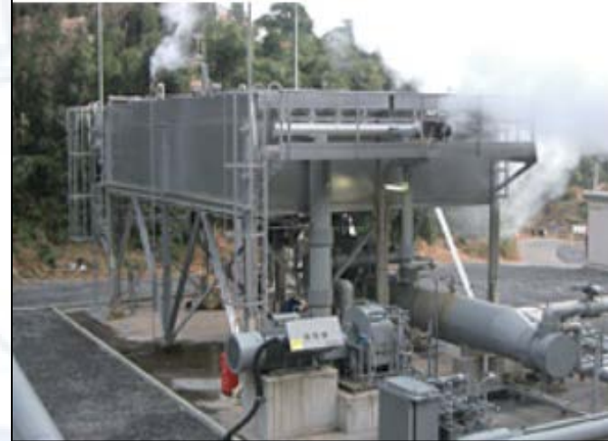
温泉郷にあり、地熱蒸気を取り入れタービンを駆動させる施設例
