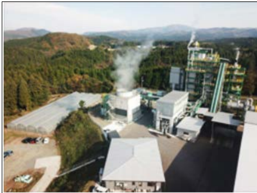
製材過程で発生する木くずを 利用した施設例
