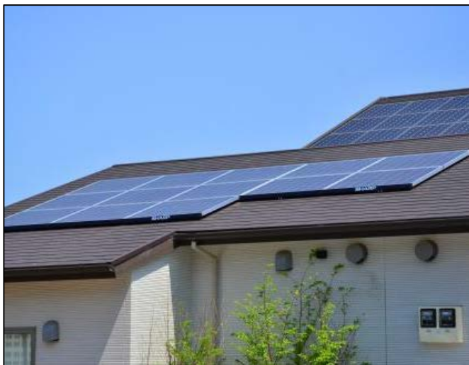
住宅の屋根に設置した例
