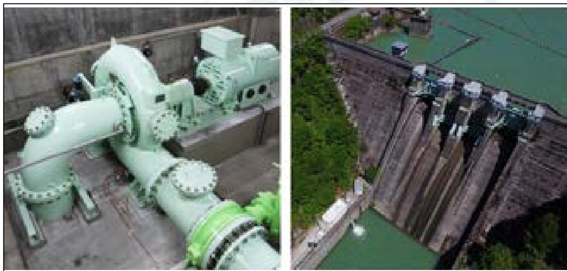
ダムを利用して設置した例
