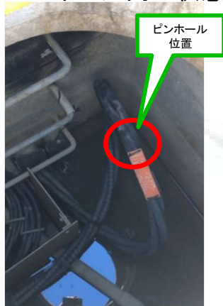
マンホール内の状態
