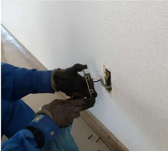
【不良コンセントの取替】
