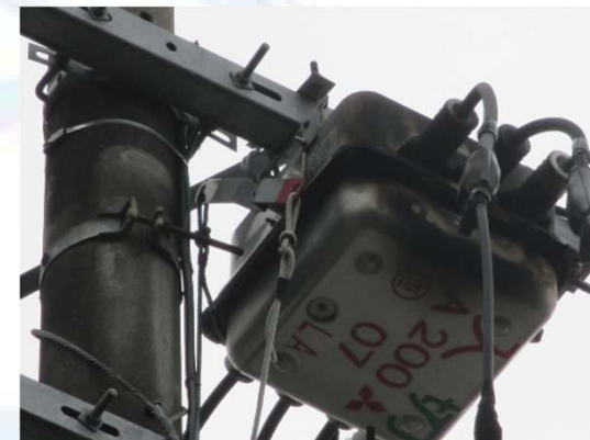
【落雷による被害を受けた開閉器】
