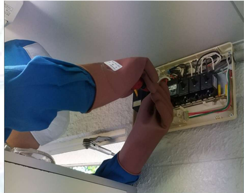
【ブレーカー接続部の増し締め】
