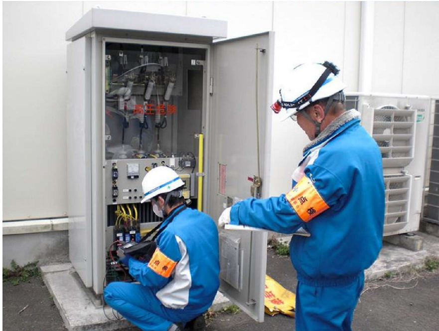
【需要設備を停電しての精密点検】
